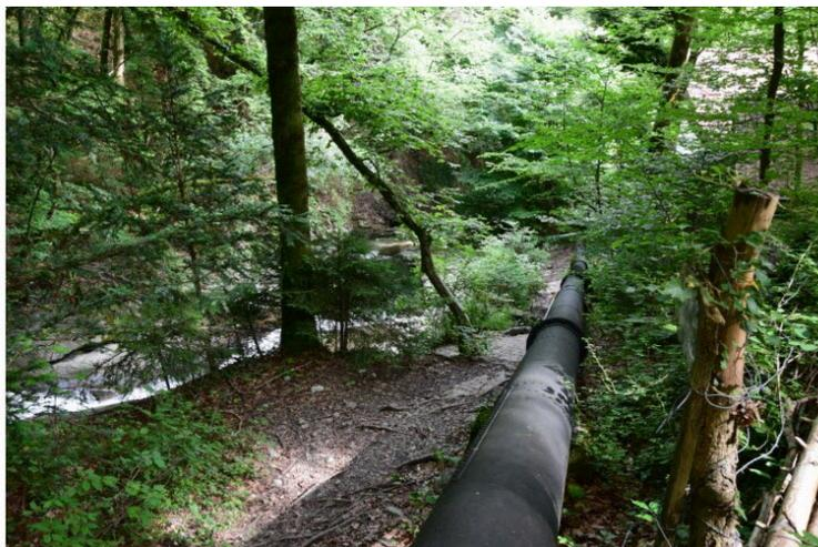
La conduite forcée alimente une turbine de type Francis qui nécessite de gros tuyaux, puisque c'est la chute de l'eau sur sept mètres qui la fait fonctionner. Au début, la famille produisait ainsi l'intégralité de son électricité. Quand il n'y avait pas assez d'eau dans le torrent, elle s'éclairait à la bougie. Photo Le DL/N.S.
